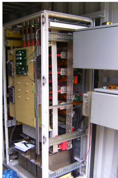
Рис. 3. Внешний вид блока понизителя мощного зарядно-разрядного комплекса Fig. 3. Exterior view of the reducing block of the powerful charge-discharge complex
