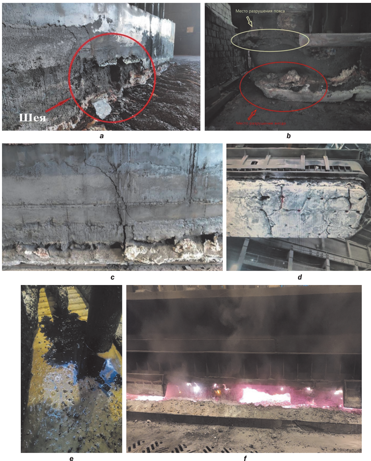
Рис. 4. Основные виды технологических нарушений при обслуживании самообжигающегося анода электролизера: а – выгорание боковой поверхности анода; б – отсутствие торцов и углов анода; с – наличие трещин в теле анода; д – образование сквозных отверстий и трещин под токоподводящими анодными сталеалюминиевыми штырями и трещин на подошве анода; е – образование на поверхности анода пековых «карманов»; ф – осыпаемость анода
