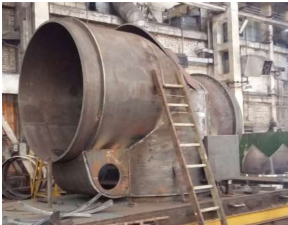
Рис. 9. Сборка корпуса клапана Иркутского завода тяжелого машиностроения (сварной корпус) Fig. 9. Assembly of the valve body produced by the Irkutsk Heavy Engineering Plant (welded body)
