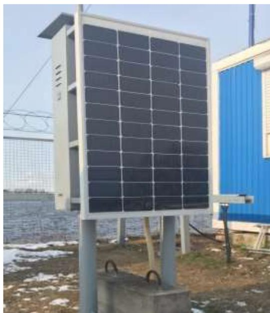
Рис. 5. Система автономного электропитания для электроснабжения технических средств охраны
