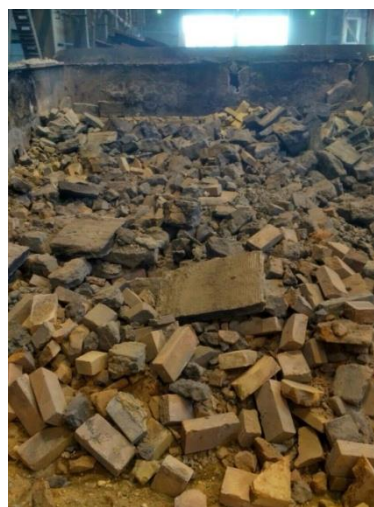
Рис. 1. Огнеупорная часть отработанной футеровки при демонтаже катодного устройства электролизера
