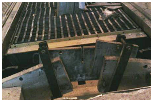
Рис. 5. Стандартная плавкая вставка, установленная на электролизер: а – до перегорания, б – после перегорания Fig. 5. A standard fusible link installed on the electrolytic cell: a – before failure, b – after failure
