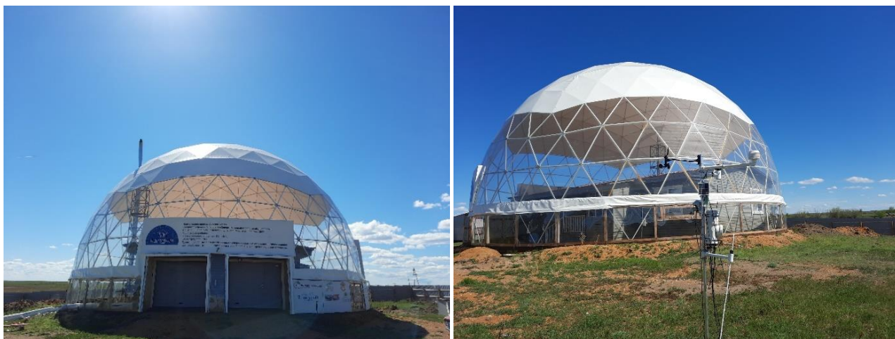
Рис. 1. Внешний вид купольного здания Fig. 1. Image of a dome building
